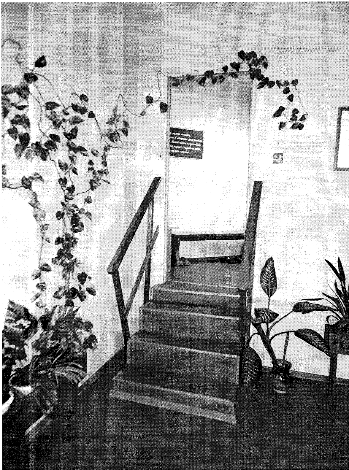
Фото № 8 Лестница для прохода в кабинет доврачебной помощи
