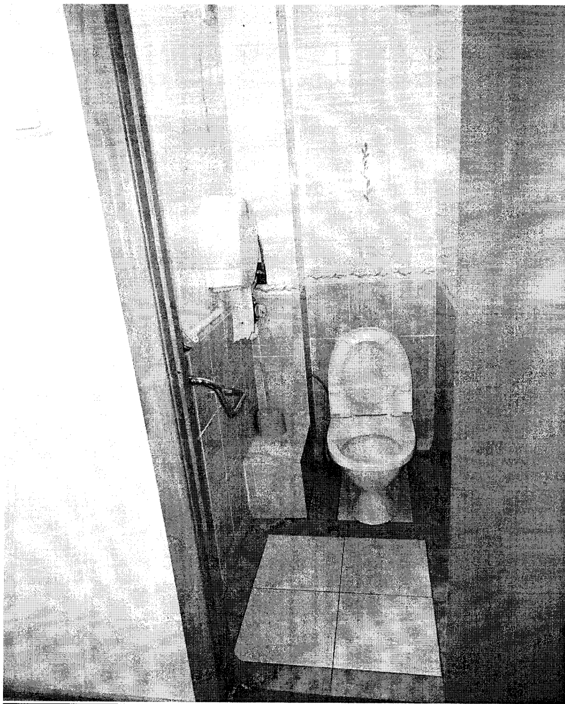
Фото № 12 Туалетная комната
