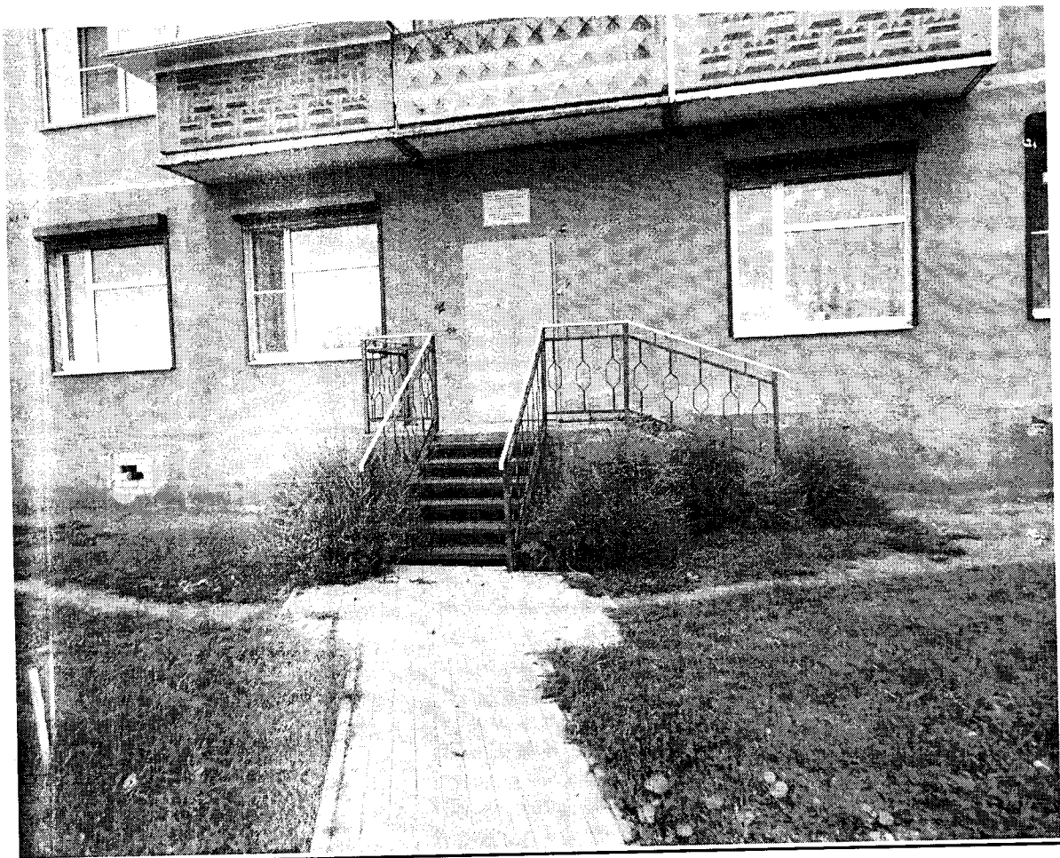
Фото №2 Вход со стороны ул. Пескарева, предназначенный для обустройства для инвалидов
